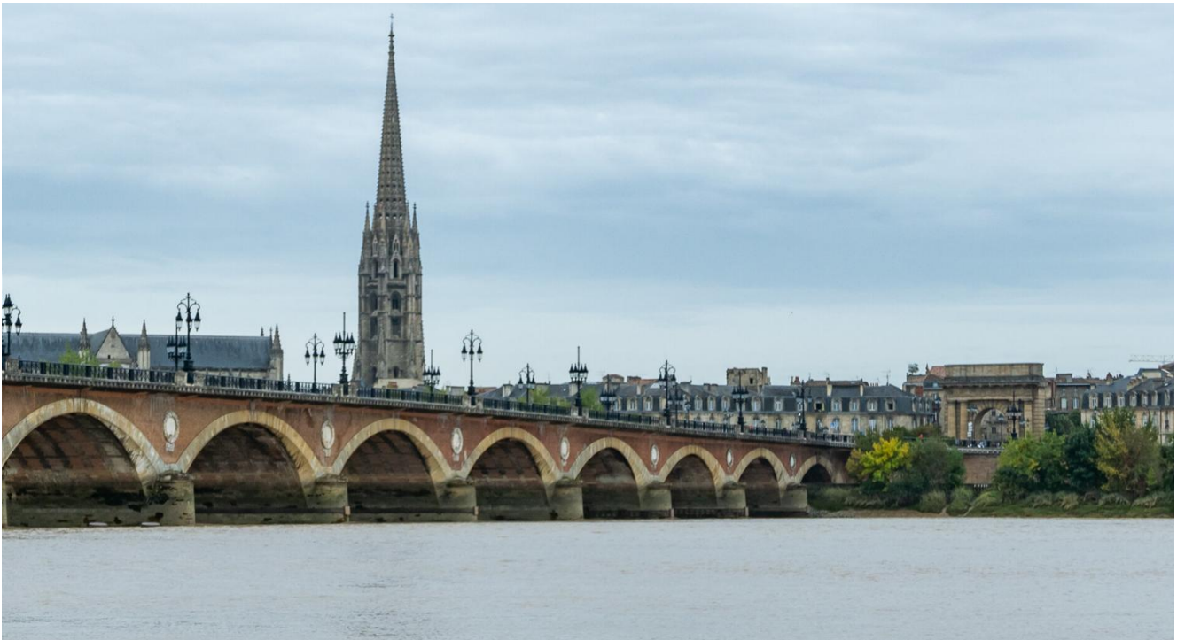
Figure 1. The Pont de Pierre of Bordeaux.
